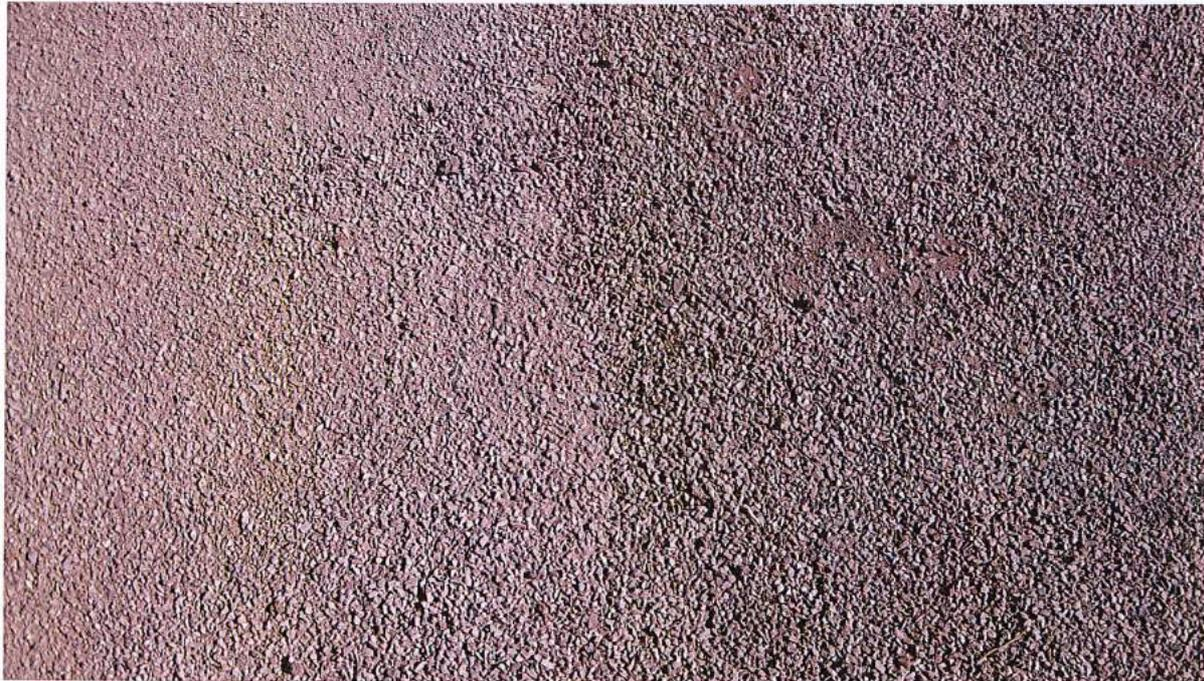
Beispiel: Wegedecken im Park am Schloss Großkochberg - links polymergebundenen Splittdecke auf Asphalt - rechts Splittdecke auf wassergebundener Decke
