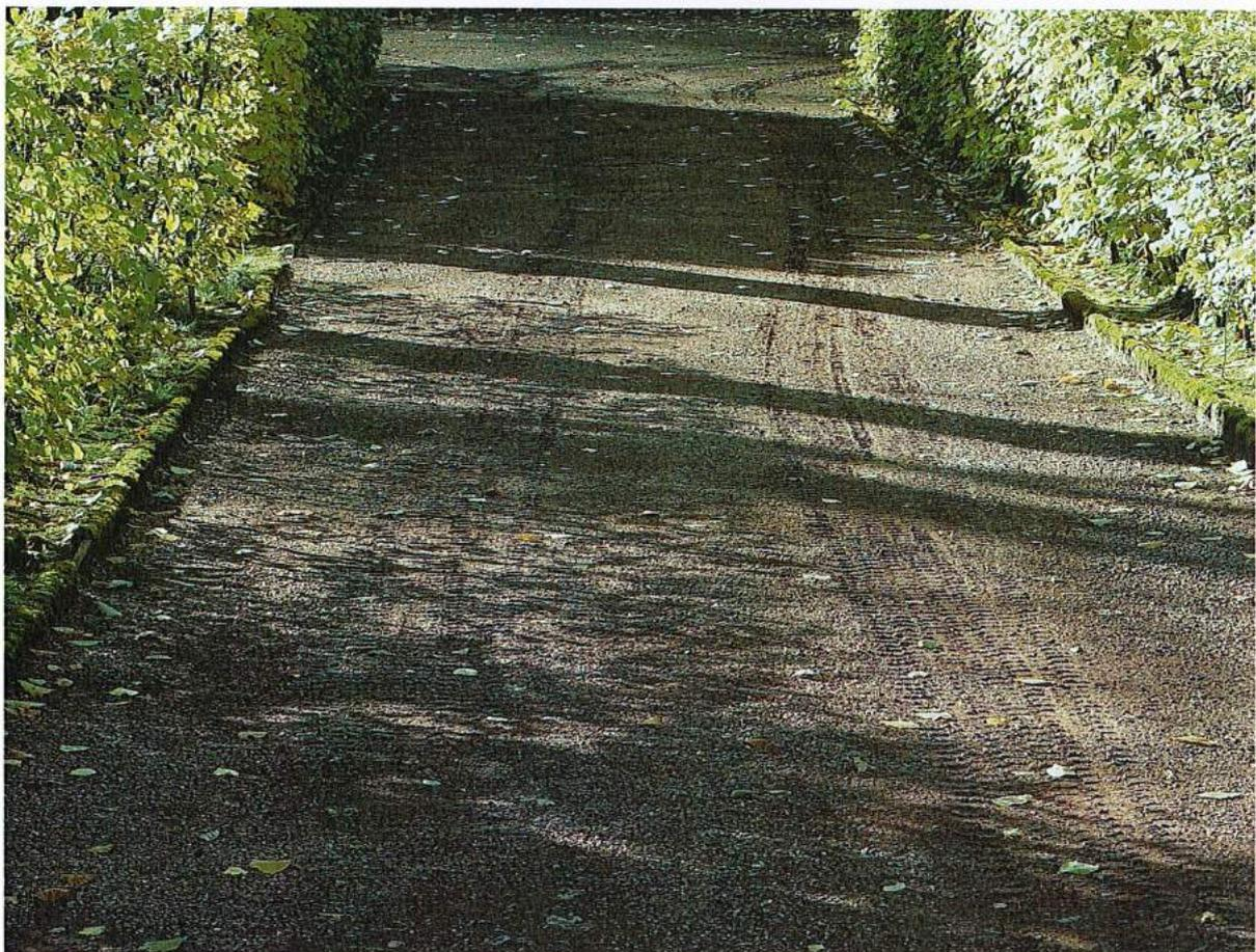
Abb. 4 - Fahrspuren in wassergebundener Decke nach starken Regenfällen
